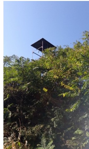
telken található trafó
