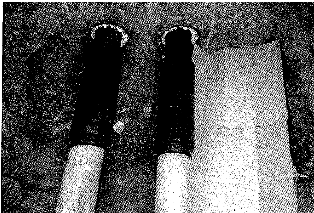
Szigetelt, zsugorcsővel lezárt vezeték
