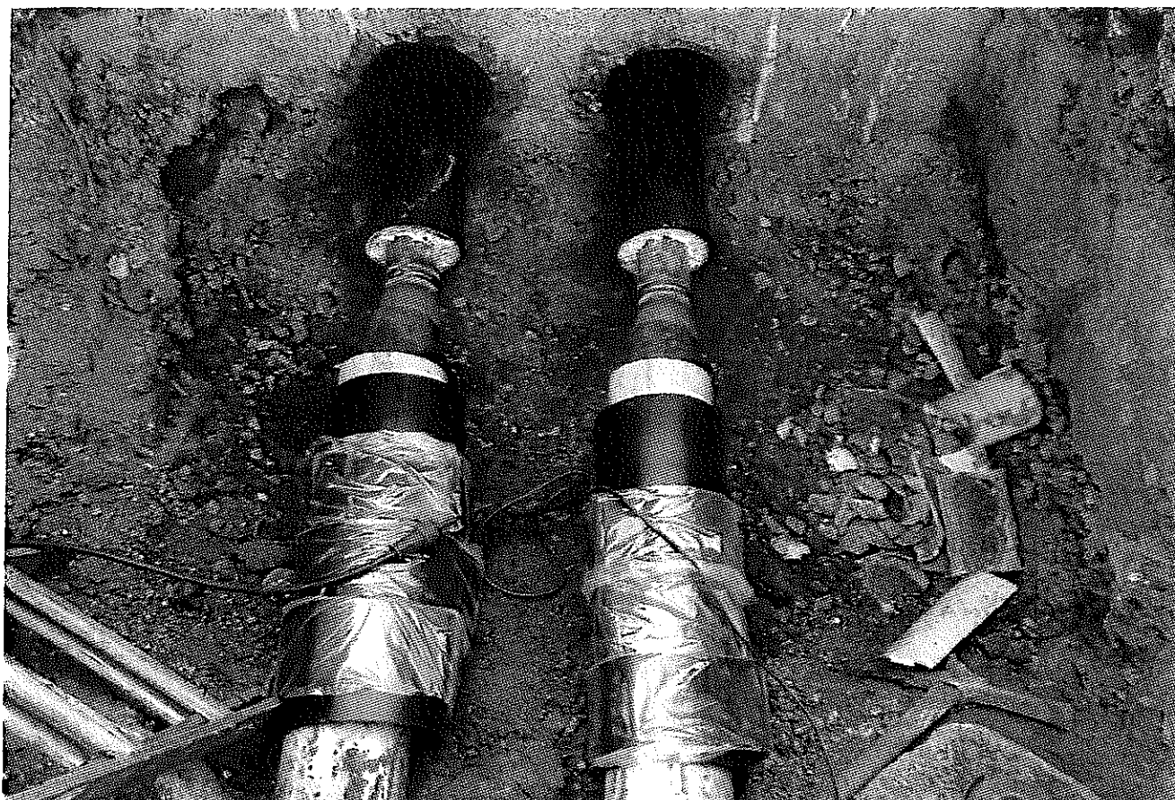
Beépített szakasz nyomáspróba alatt, lezárás előtt
